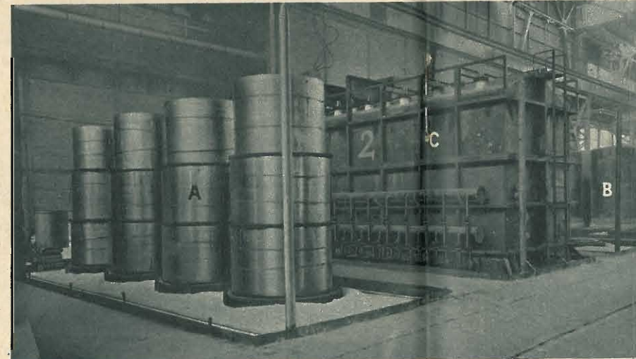
5 Reparto dei forni da ricottura. I rotoli di lamiera semilavorata (A) vengono posti in atmosfera neutra sotto le campane (B) che saranno poi ricoperte dal forno da ricottura.
